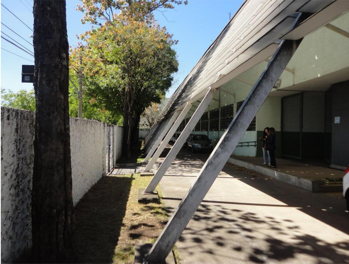
**Figura 6:** Vista interna da estrutura de brises a partir do pavimento térreo. Fonte: Acervo ArtArqBr.
